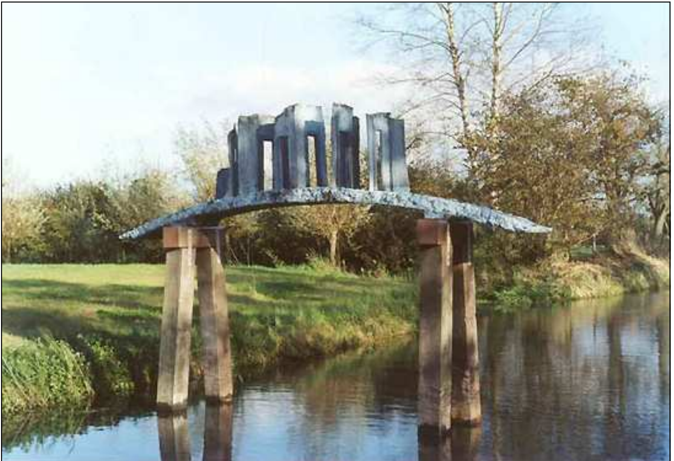
Bebouwde brug - Langbroek (2000)
